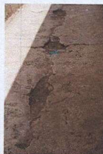
FOTO NO. 4 Reparación de cuneta de concreto con fisuras y levantada en área posterior de aula 1, aula 2 y aula 3
