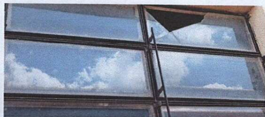
FOTO NO. 3 Sustitución de ventanas de metal, por ventana de PVC de 1.08*1.08 en área de cocina
