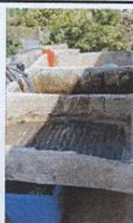
FOTO NO. 5 Sustitución de pila quebrada, por pila de concreto a la par de cocina
